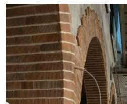
施工されたスクラッチタイル
