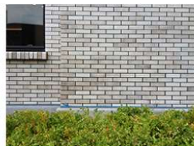
再現された外壁
