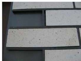
モルタル除去・洗浄により再利用する既存タイル
