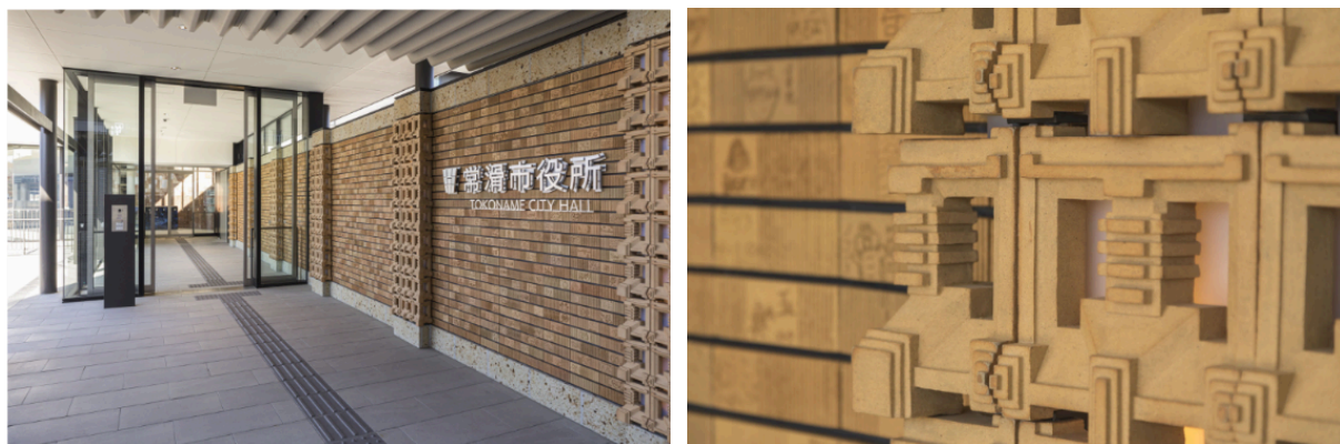
（写真）スクラッチタイルとテラコッタが採用された常滑市役所新庁舎 2階 正面玄関
