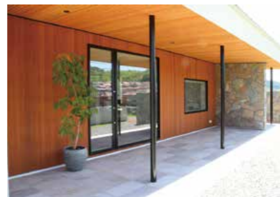
杉板をリブ状に加工した軒天。減築しつつもテラスを増築。天然石を取り入れ、アイアンと窓枠はブラックで統一した、モダンでリゾートライクな演出。
