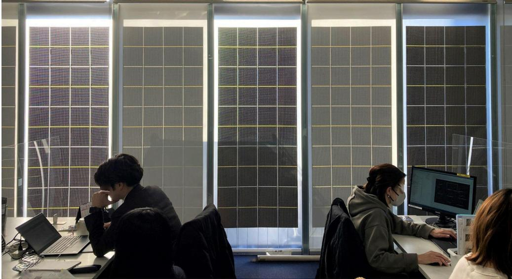
また、屋根や壁面に設置する太陽光発電設備と比べ、少ない手間やコストで設置でき、メンテナンスも室内側から容易に行うことができます。「PVロールスクリーンシステム」を日本で設置可能な窓(1.4億 $m^{2*1}$ )のすべてに導入した場合、CO<sub>2</sub>排出削減量が建設セクターの2030年削減目標の約12%に相当することが試算されています<sup>\*2</sup>。そのため、脱炭素への貢献する製品としての開発と普及を進めています。
