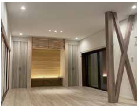
間仕切られていた3つの居室を広々としたワンルームのLDKに一新。耐震対策の筋交は、空間のアクセントに。
